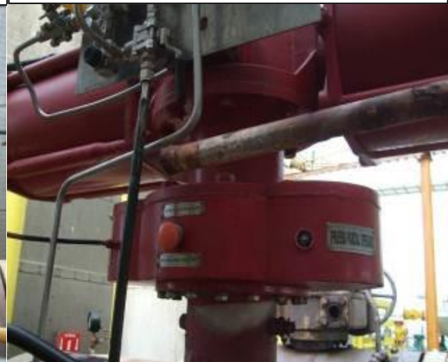
Fig. 7. Dispositivo mecánico para realizar las pruebas de cierre parcial en la Válvula de SDV del oleogasoducto de salida a Akal-C; Clave 147-B. Este dispositivo mecánico coincide con lo requerido en las bases de usuario del proyecto.
