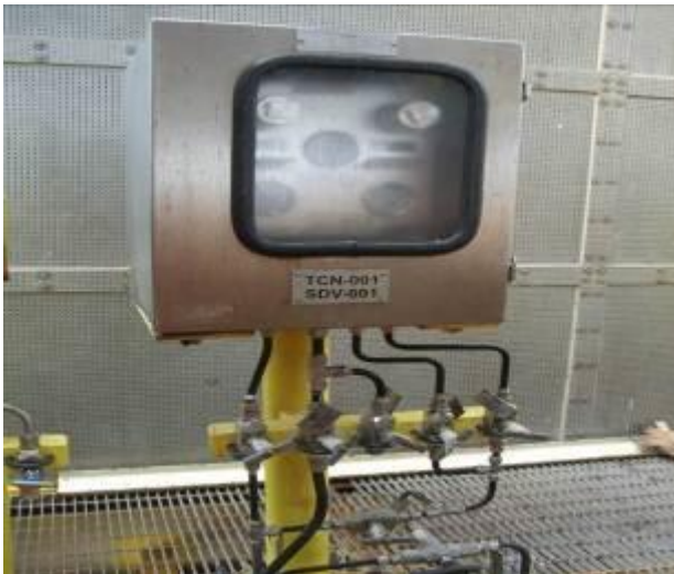
Fig. 8. Tablero de control neumático de la válvula SDV con interruptores por alta y baja presión del oleogasoducto de salida a Akal-C; Clave 147-B. Este dispositivo neumático coincide con lo requerido en las bases de usuario del proyecto.
