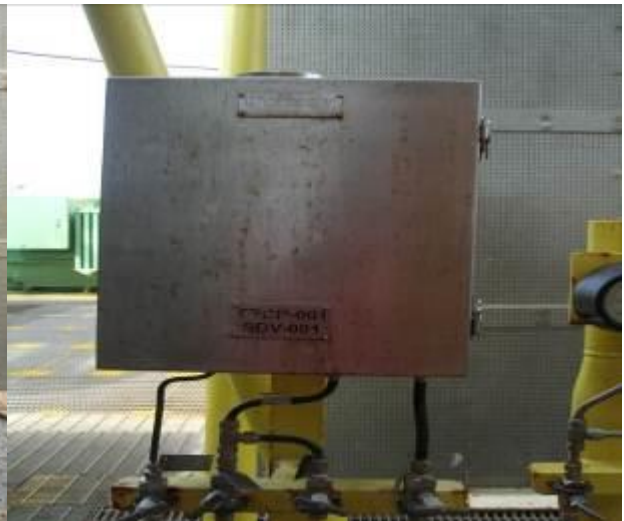
Fig. 9. Tablero de prueba de cierre parcial neumático de la válvula SDV del oleogasoducto de salida a Akal-C; Clave 147-B. Este dispositivo neumático coincide con lo requerido en las bases de usuario del proyecto.
