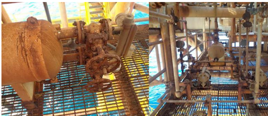
Fig 3. Localización de tanque y bomba de drenaje atmosférico fuera de servicio
