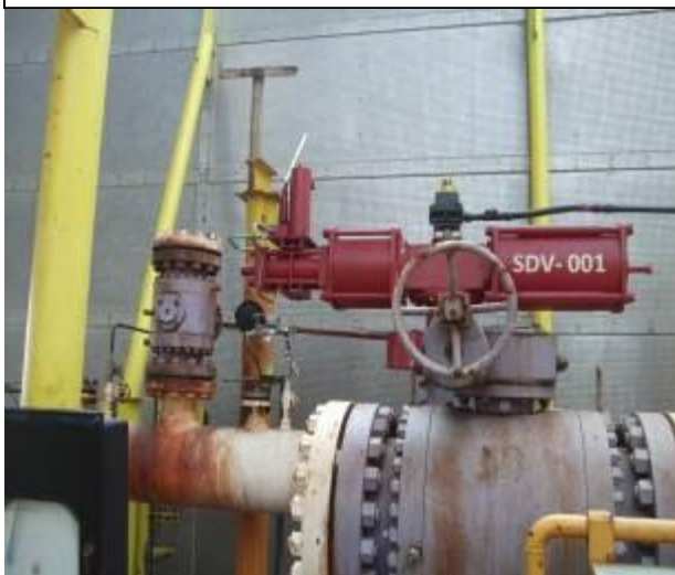
Fig. 6. Válvula de SDV con actuador neumático de simple acción de retorno por resorte con bomba hidráulica para apertura con tablero de control neumático para cierre de emergencia a través del monitoreo de la presión del oleogasoducto de salida a Akal-C; Clave 147-B. Cabe mencionar que esta válvula SDV no cuenta con los instrumentos de presión en voto 2003 para el Sistema SPPE de la plataforma PP-Balam-TB.
