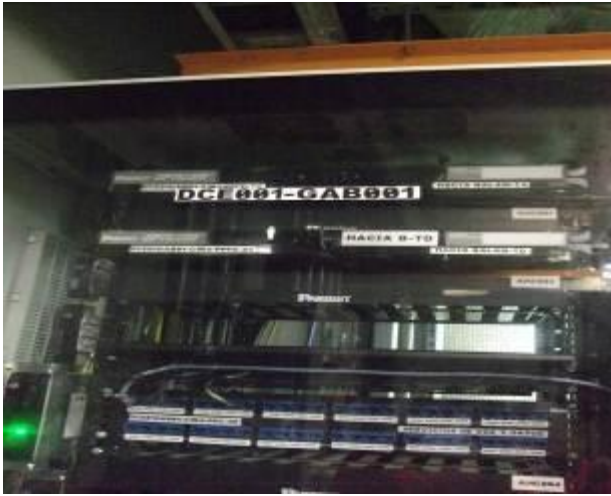
Fig. 4. Gabinete de comunicaciones DCE001-GAB001 donde remata las señales de comunicación Modbus RTU/ TCP IP provenientes del Gateway Smart Wireless de los instrumentos inalámbricos en campo de la Plataforma de Perforación PP-Balam-A. Los datos son enviados desde este Gabinete DCE001-GAB001 hacia la plataforma PP-Ek-A via enlace de fibra óptica submarina donde son monitoreados por el Sistema PI Process.
